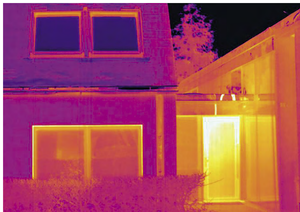
Thermografie von aussen zur Visualisierung von Wärmeverlusten
