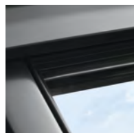
Lamiera esterna in alluminio grigio umbro, con vernice a fuoco, NCS S 7500-N, all'incirca RAL 7043
