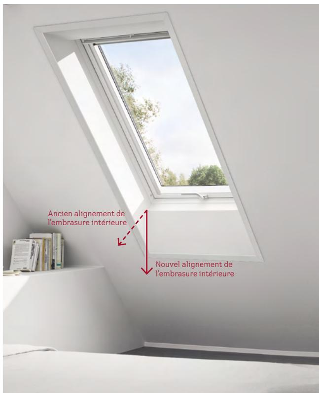
Il est toujours recommandé de prévoir la pose d'une nouvelle isolation tout autour de la fenêtre et d'une nouvelle embrasure intérieure lors du remplacement d'une fenêtre, afin d'obtenir un raccord de la fenêtre à la toiture optimal sur le plan énergétique. En outre, les embrasures intérieures n'étaient souvent pas évasées, si bien qu'il pénétrait moins de lumière du jour dans la pièce.
