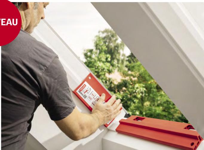
Le nouveau Protect Tool assure une protection optimale du cadre applique lors de l'accrochage et du décrochage du vantail. À enclipser simplement en bas et sur les côtés inférieurs du cadre applique.
