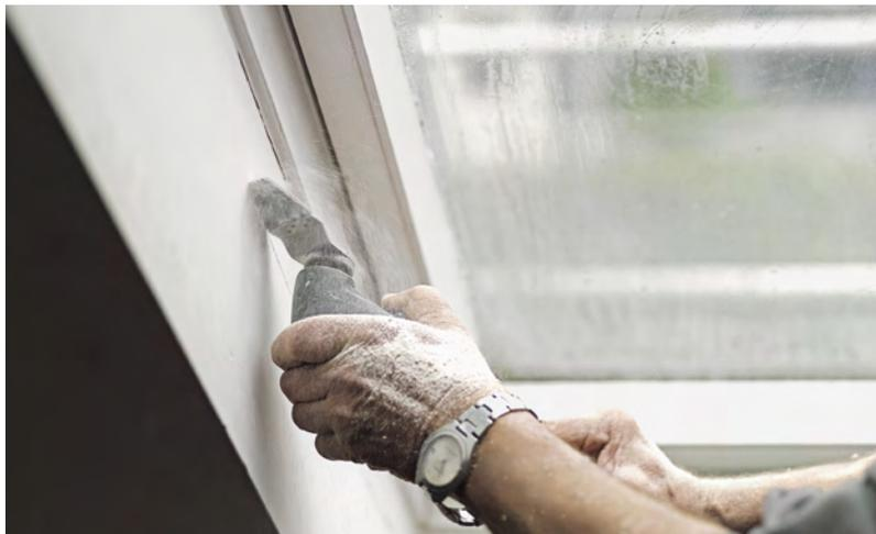
Si il faut absolument garder l'embrasure intérieure, il est possible de l'adapter au niveau de montage ou de la recouper. Veuillez tenir compte de ce qui suit: Si, pour une raison quelconque, l'ancienne embrasure n'est plus d'équerre, la nouvelle fenêtre ne peut pas être montée correctement, ce qui empêche également de réaliser des améliorations énergétiques.
