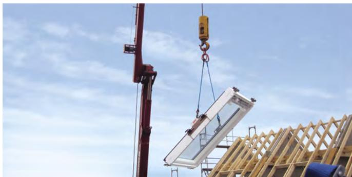
Grâce au nouveau système de levage, le montage de grandes fenêtres de toit lourdes s'effectue rapidement et aisément. Il permet de poser de l'extérieur la fenêtre de toit directement dans la découpe de toit préparée à l'aide d'ellingue, réduisant ainsi les sollicitations corporelles et faisant gagner du temps à l'installateur.
