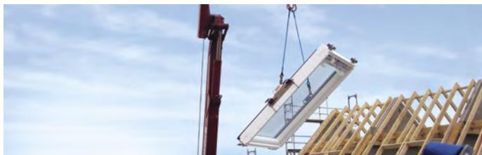
Grâce au nouveau système de levage, le montage de grandes fenêtres de toit lourdes s'effectue rapidement et aisément. Il permet de poser de l'extérieur la fenêtre de toit directement dans la découpe de toit préparée à l'aide d'ellingue, réduisant ainsi les sollicitations corporelles et faisant gagner du temps à l'installateur.
