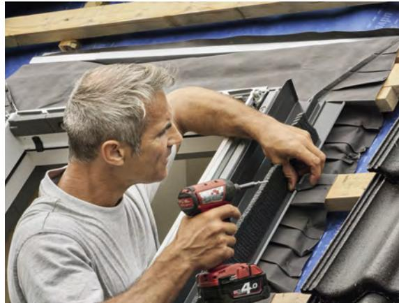
Vis magnétiques à la place des clous. Pas d'outil supplémentaire nécessaire pour le processus de montage.
