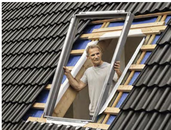
Cadre d'isolation BDX dans une nouvelle hauteur de profil BDX 2000 = 105 mm à la place de 90 mm – plus de matériau isolant pour un montage sûr.
